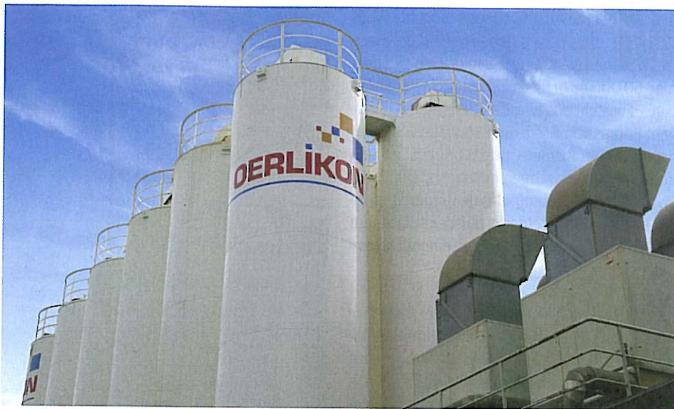
Wird von Air Liquide weiter ausgebaut: der Oerlikon-Standort Eisenberg in der Pfalz
